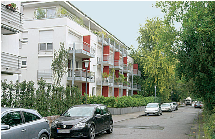
Beispiel einer Umnutzung eines Universitätsgebäudes für eine gehobene Wohnnutzung
