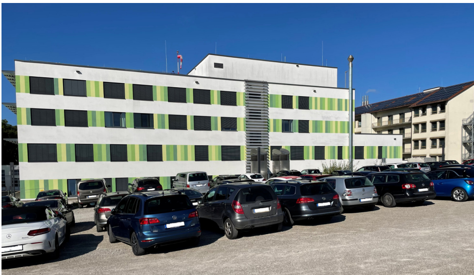
Auf diesem Parkplatz entsteht der Klinikneubau. Mit den vorbereitenden Baumaßnahmen wurde Anfang Oktober 2021 begonnen.
