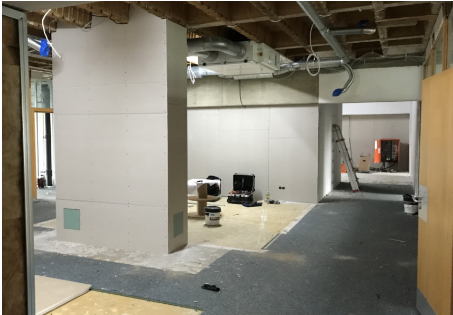
Innensanierung der Kaufmännischen Schule Schwäbisch Hall
