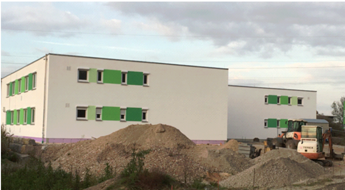
2 Flüchtlingsheime in Modulbauweise in Ilshofen
