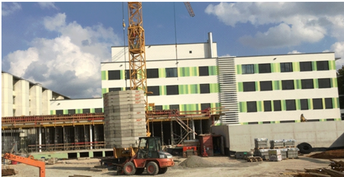
Das Bild zeigt den Rohbau der Eingangshalle und dahinter den Klinikneubau.
